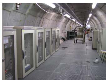
Links: On-line water en gas staalname/analyse systeem, gemonteerd als deel van de PRACLAY verwarmingstest, om de evolutie van de chemische parameters door opwarming op te volgen.
