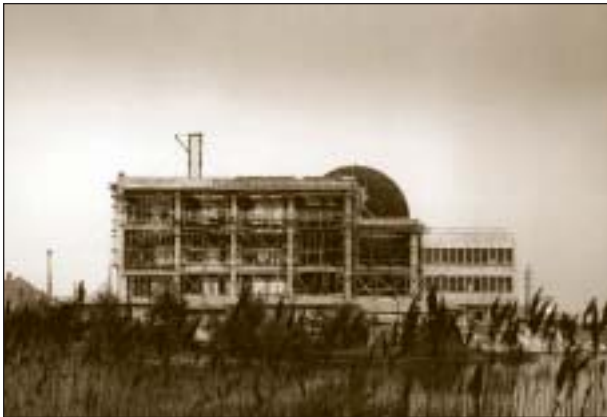
De bouw van BR3
