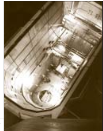
Het reactordok voor de montage van de reactor
