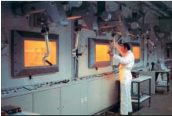
Afgeschermdde cellen in het PAMELA gebouw (Foto Belgoprocess)
