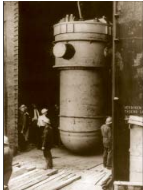
Het binnenbrengen van de reactorkuip van BR3
