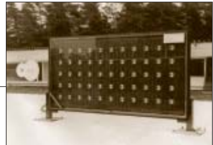
De zonnecollectoren op het dak van het gebouw Zonnecellen
