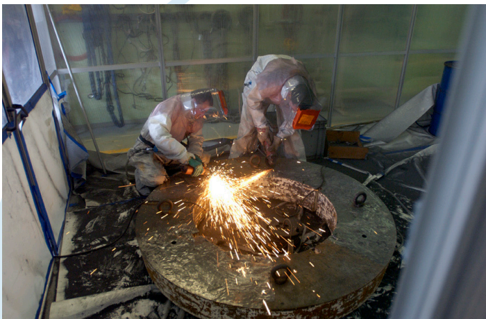
Ontmanteling van Belgian Reactor 3 (BR3) in geventileerde cabine.
