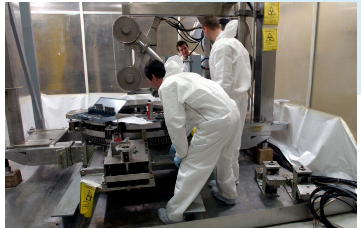
Het snijden van onderdelen van BR3 met een zaag.
